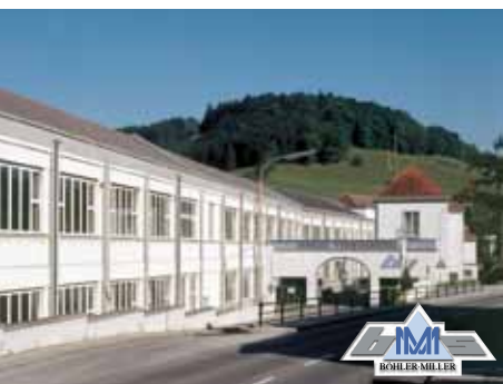
Böhler-Miller Messer- u. Sägen GmbH, Böhlerwerk Sales and Production
